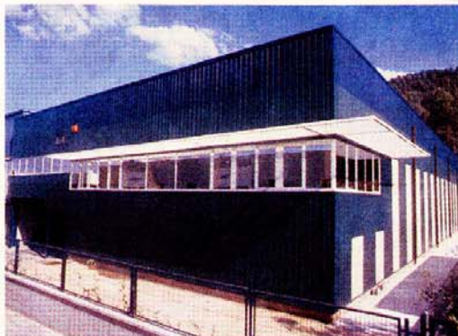
Fachada de General de Archivo y Depósito
